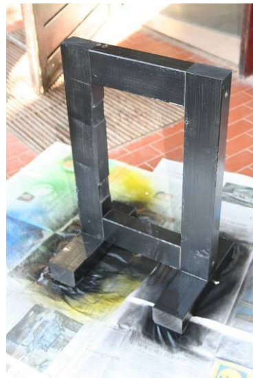
Slika 9 in 10: Barvanje okvirja za vrata
