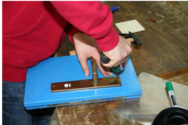
Slika 7 in 8: Predelava kljuge in ključavnice ter namestitev nove na vratno krilo
